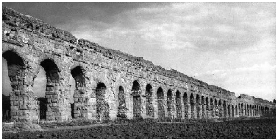
8. La Aqua Claudia, uno de los nueve acueductos que abastecían a Roma en 64 d. C., todavía atraviesa la campiña italiana de camino hacia Roma.
